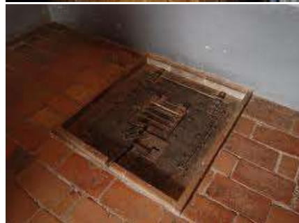
La cella di Cagliostro e la botola di accesso
